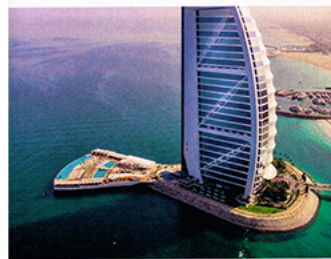
Yksi Dubain maamerkeistä. Dubain Burj Al Arab -hotellin yhteyteen tehty teräsrakenteinen saari on turkulaisen Admaresin rakentama. Kudos Dsign oli mukana suunnittelussa projektinjohtajana maailman upeimpien risteilylaivojen sisustuksia.
